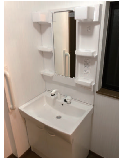
給水・給湯を配管し直して 脱衣場に移設した新しい洗面化粧台
