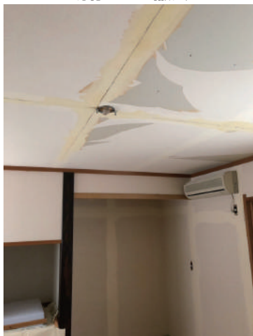
既存クロス撤去
