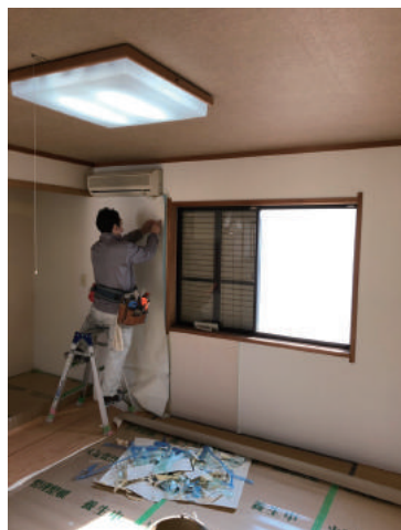
クロスの張替え作業
